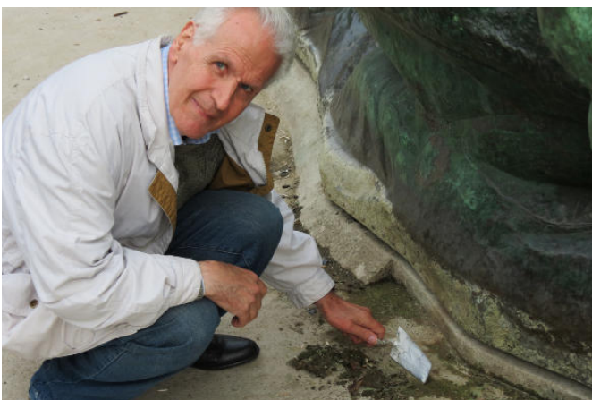
Kostenfreie Reparatur am beschädigten Betonsockel des Stuhlmann-Brunnens 2014 - durch das Altonaer Stadtarchiv
